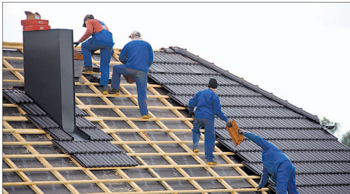
Bietergemeinschaften für Aufträge sind grundsätzlich Einzelbieter gleichzusetzen.
