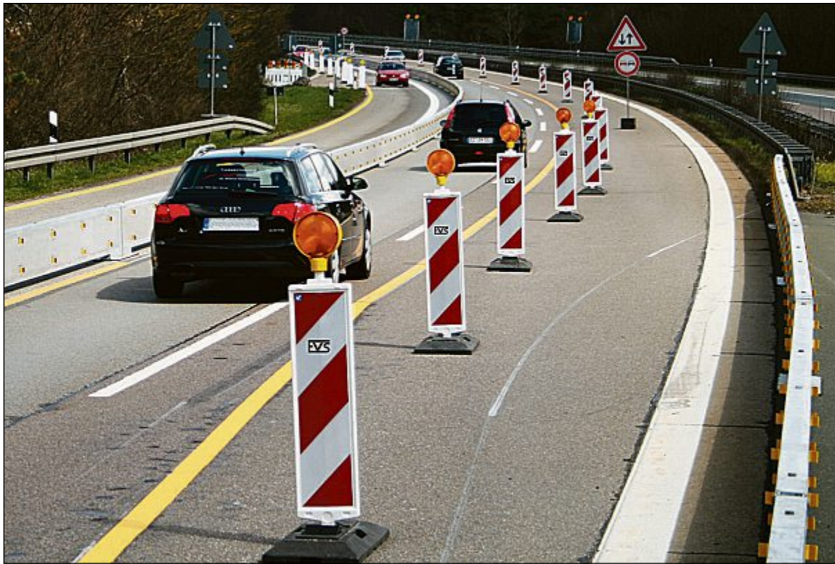
Auch bei Baustellenabsicherungen ist ein Vergabeverfahren nötig.
