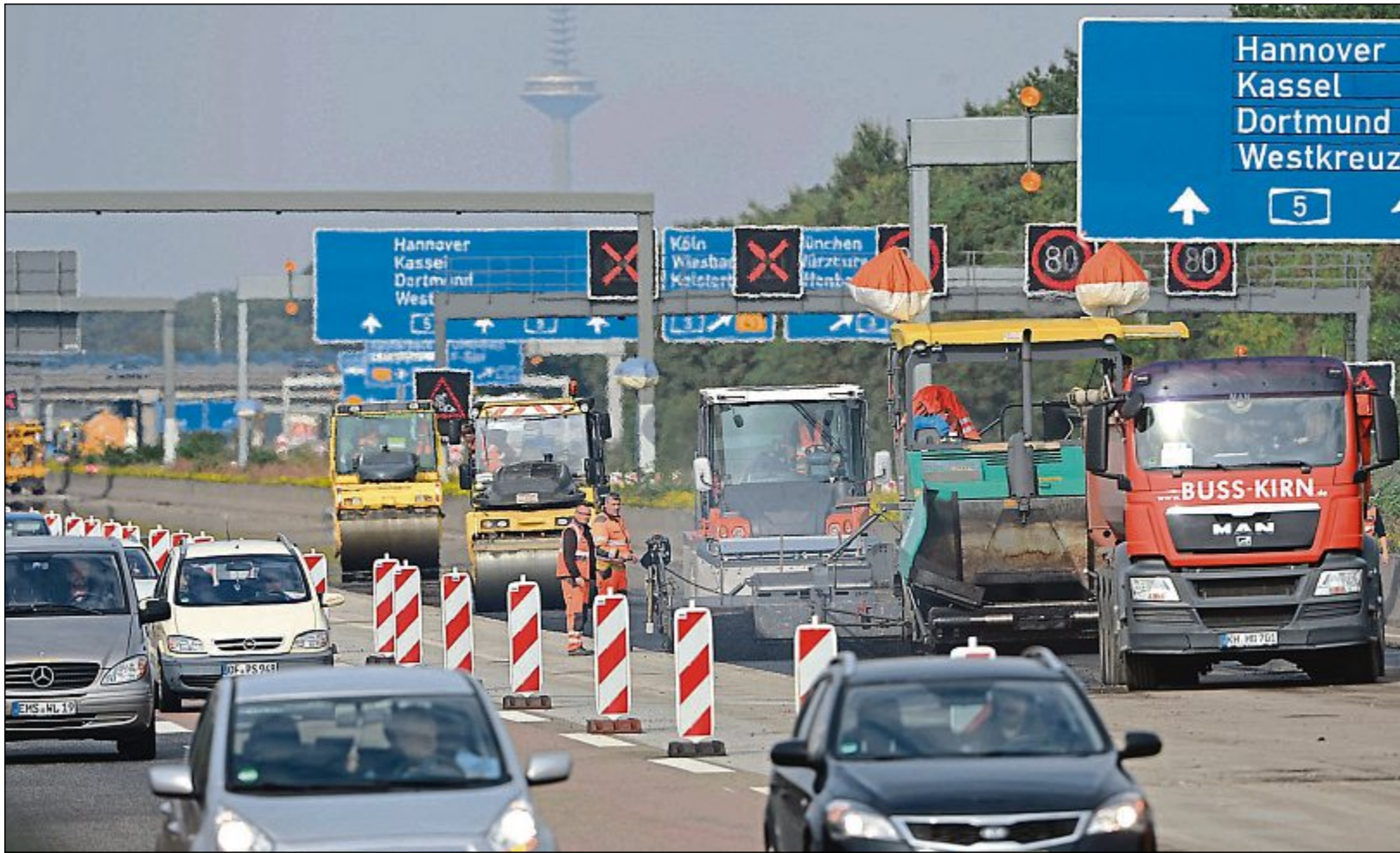
Bei der Ausschreibung von Fahrbahnerneuerungsarbeiten an der Bundesautobahn A 5 hob die zuständige Vergabekammer das Verfahren auf. FOTO DPA
