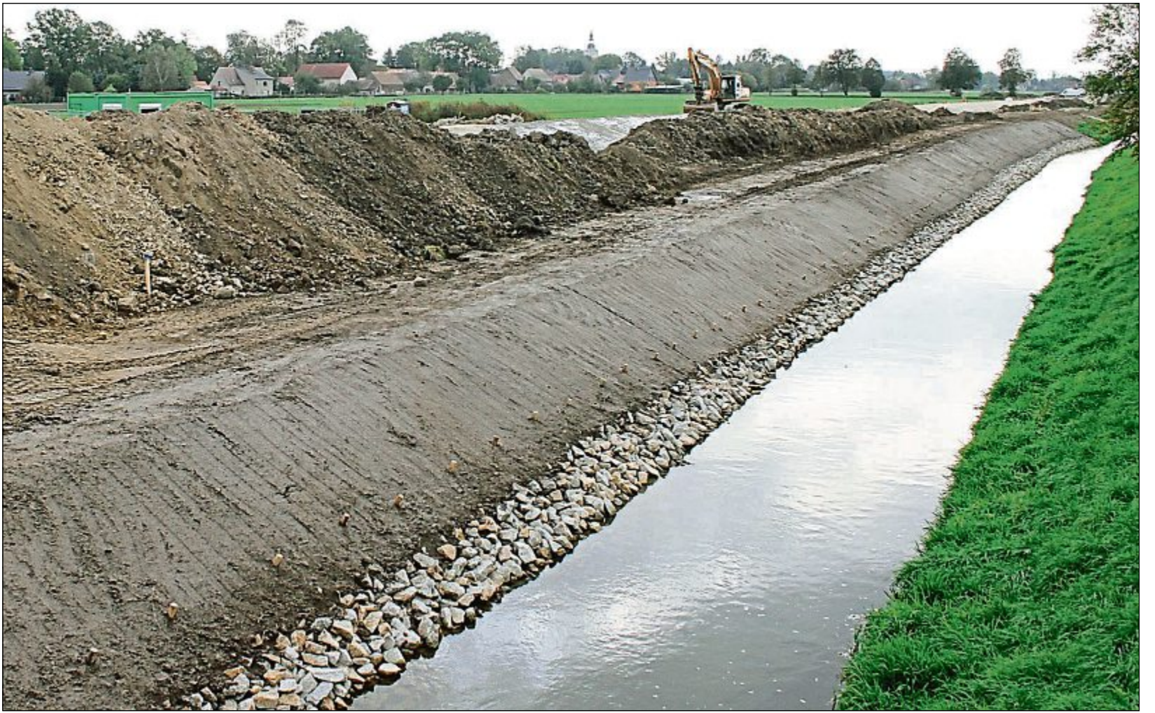
Beim Bau einer Hochwasserschutzmaßnahme gab es Streit.
