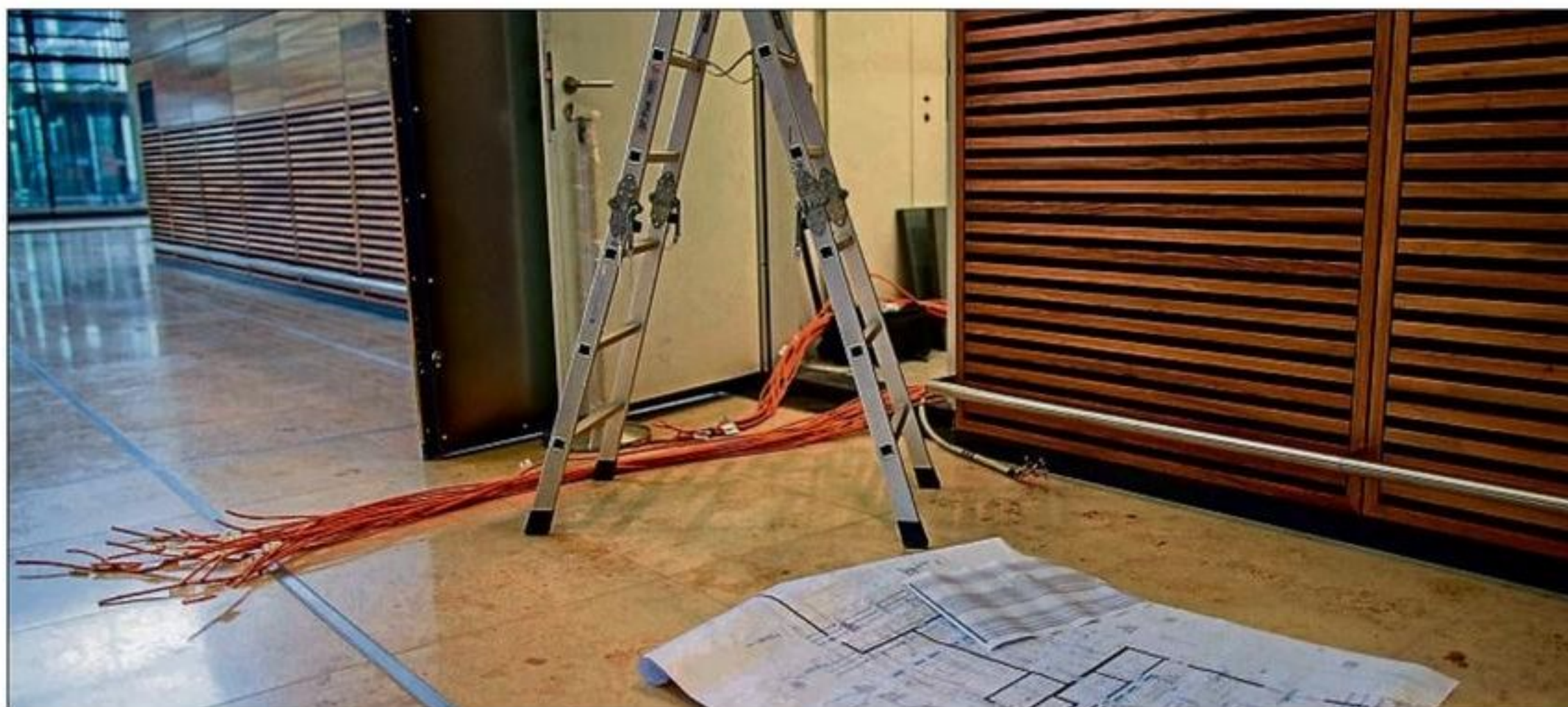
Um möglichst viel Flexibilität zu haben und bei Wunsch den Planer doch als Bauüberwacher behalten zu können, werden in vielen Fällen die Planungsleistungen nur bis zur Leistungsphase vier fest vergeben, die nachfolgenden Leistungen nur als Option. FOTO DPA
