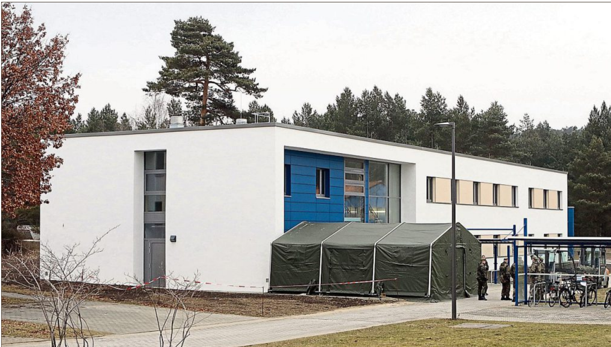
Um die Erstellung von Unterkunftsgebäuden gab es Streit.
