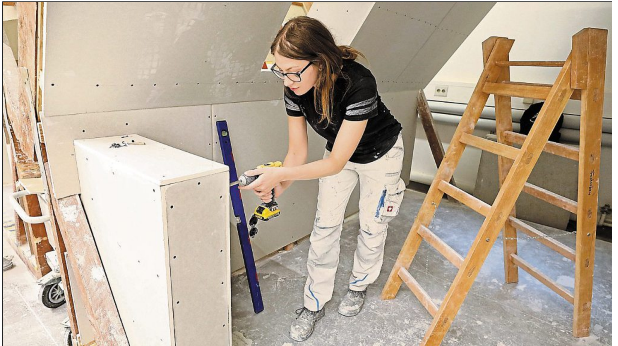
Bei der Vergabe von Trockenbauarbeiten gab es Streit.
