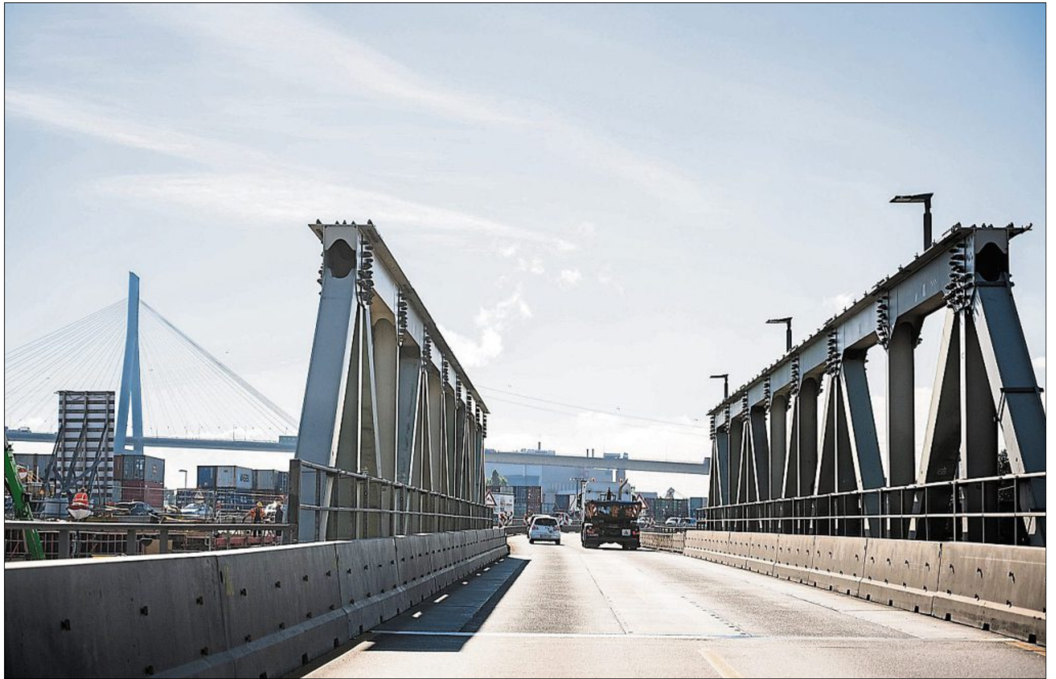
Um die Vergabe zur Errichtung von Behelfsbrücken gab es Streit.
