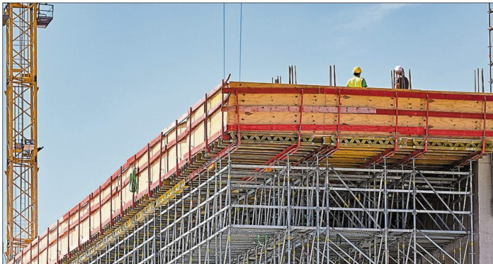
Um die Vergabe von Rohbauarbeiten gab es Streit.
