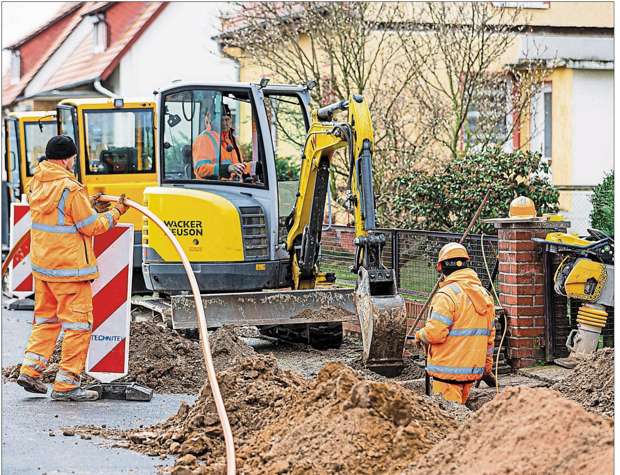
Um den Bau eines Glasfasernetzes gab es Streit.
